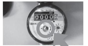
▲水道メーター漏水するとパイロット(丸い部分)が常に動きます
