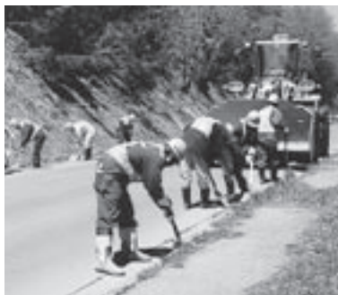
▲道路脇にたまった土砂を取り除く
