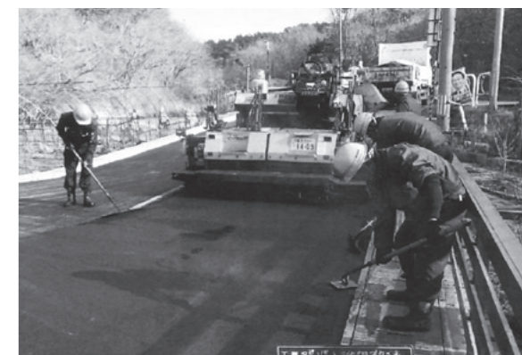
▲土屋線道路改良工事の様子
