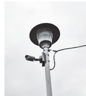
▲設置された防犯カメラ
