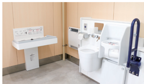
▲ベビーシートやオストメイトが設置されたバリアフリートイレ
