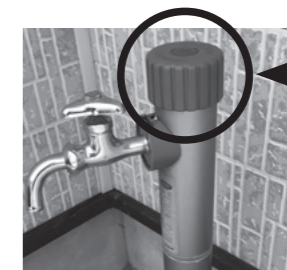
水抜栓は、水道管の凍結を防止するための器具です
