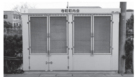
▲寺町町内会(5台整備)
