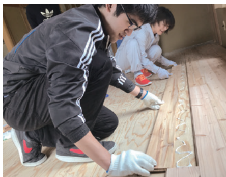
▲ずれないように注意して「フローリング貼り」の作業を行う参加者
