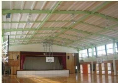
ノンフロン湿式不燃断熱材を吹付
