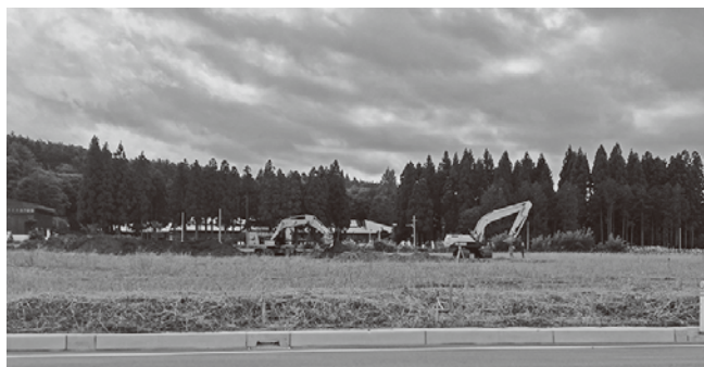
整地工事の中の新庁舎建設予定地
