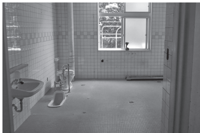
改修工事中のトイレ
