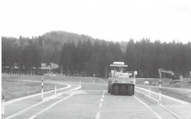
進む庁舎予定地の道路工事
