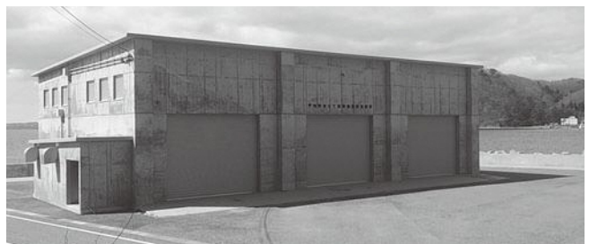
稼働が待たれる一時集積施設（茂浦地区）
