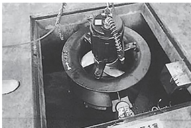
西平内処理場暖気機 装置修繕
