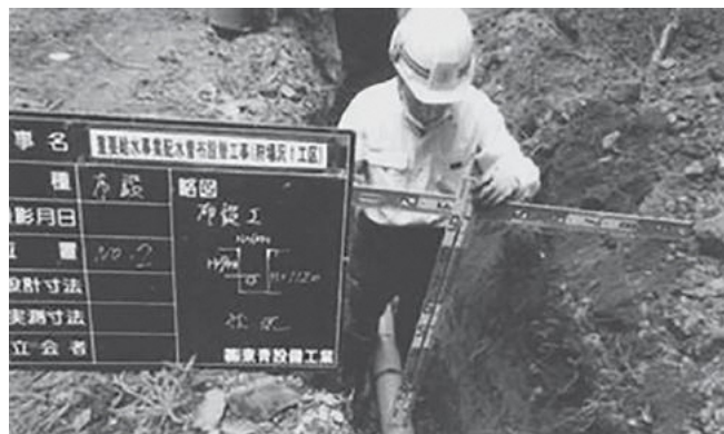
狩場沢地区配水管布設替工事
