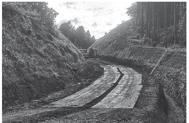
増田側 新設道路を工事中
