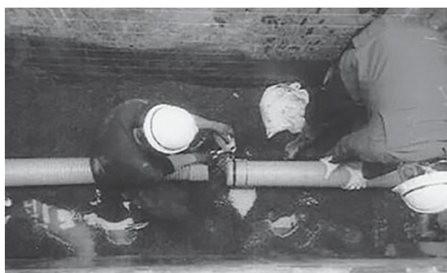
小湊地区 污水管布設工事
