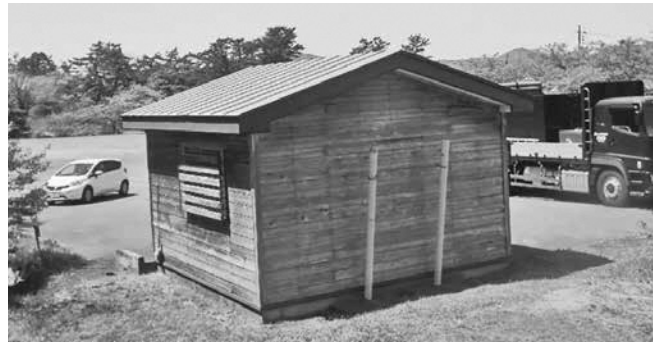
解体します 汲み取り式トイレ
