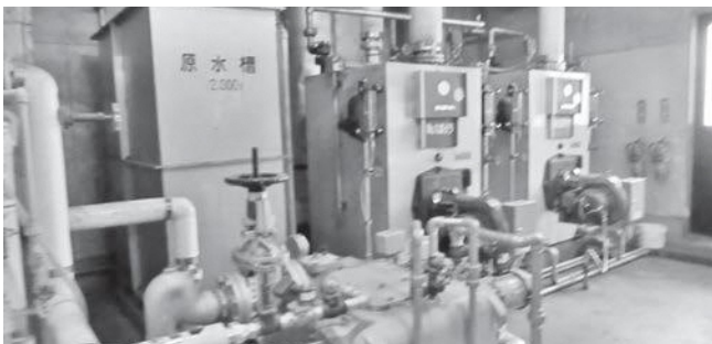
ボイラー修繕
