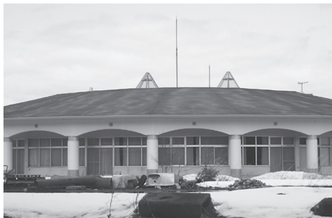
築20年の「いきいき健康館」の屋根等改修
