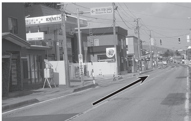
29年度工事区間 ガソリストランド付近～歩道橋 山手
