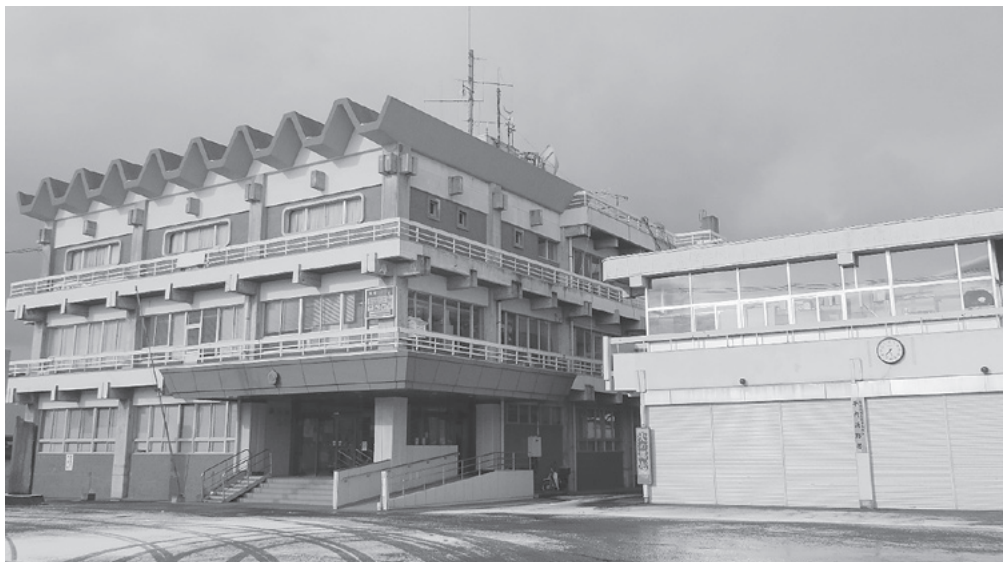
昭和42年に建てられた役場庁舎
