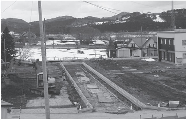
建設中の町営住宅
