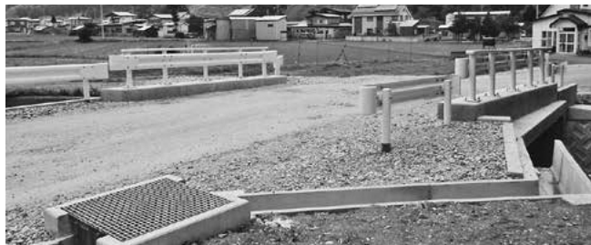
内童子向川橋の未舗装町道（6月末）
