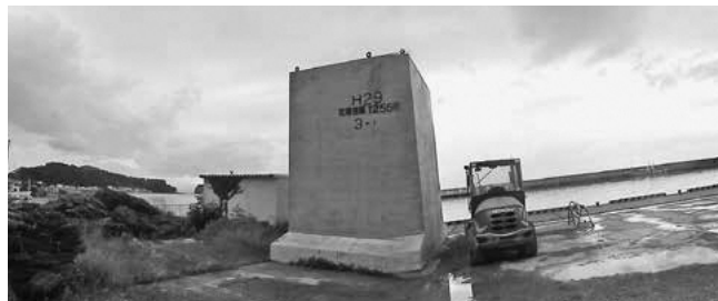
土屋支所内にブロック仮置き
