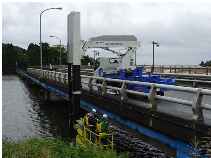
写真 4-1 従来の点検方法（橋梁点検車）
