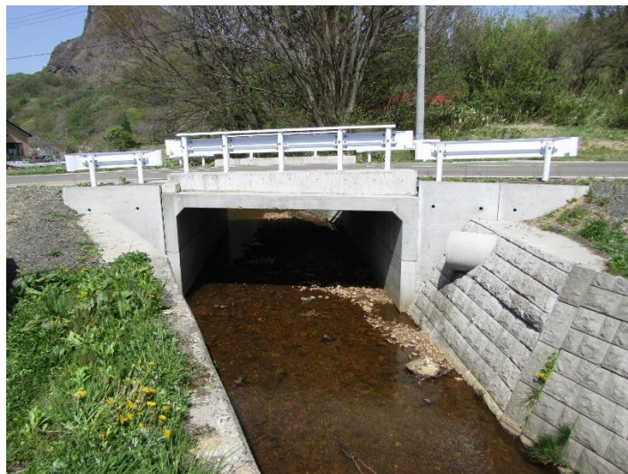
写真 6-1 ボックスカルバート構造の橋梁
